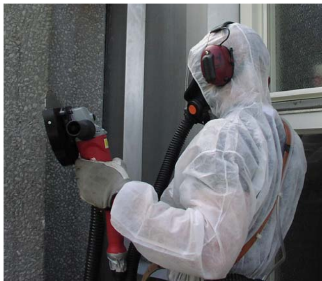
Bild 10: Testkåpa för vinkelslip med 180 mm klinga för slipning i innerhörn. Kåpan gav inte den önskade åtkomlig heten och dammuppsamlingen blev därför inte acceptabel.
